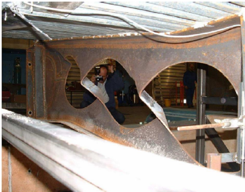
Figura 2.28 - Colapso por flambagem do montante de alma por força cortante em viga celular
