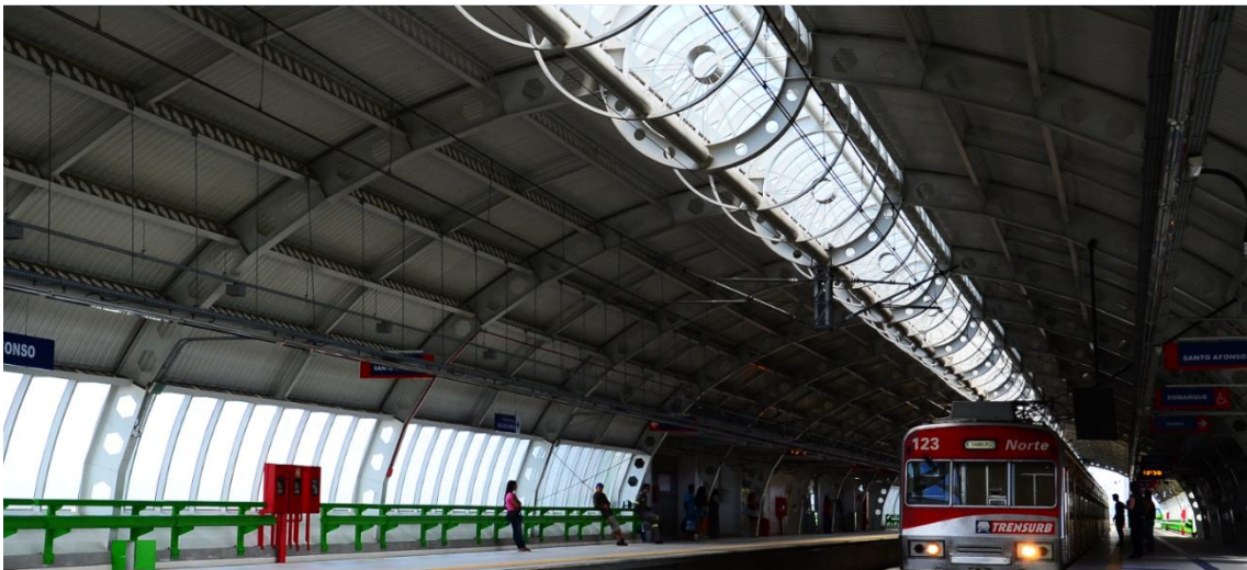
Figura 2.4 – Estrutura em arco com vigas casteladas na Estação Santo Afonso em Novo Hamburgo-RS
