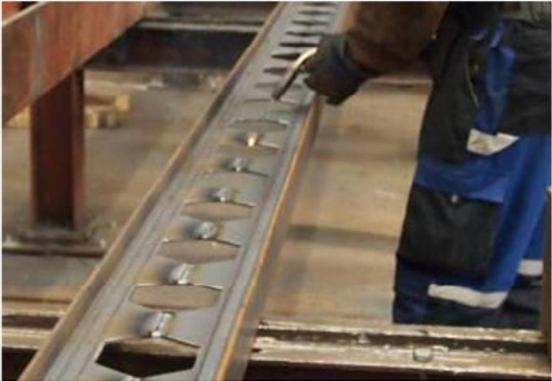
Figura 2.13 – Processo de soldagem na fabricação das vigas casteladas
