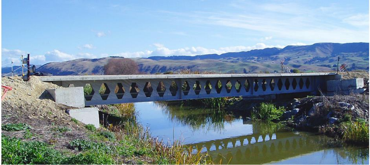
Figura 2.1 – Ponte de baixo tráfego em viga de aço castelada na Nova Zelândia
