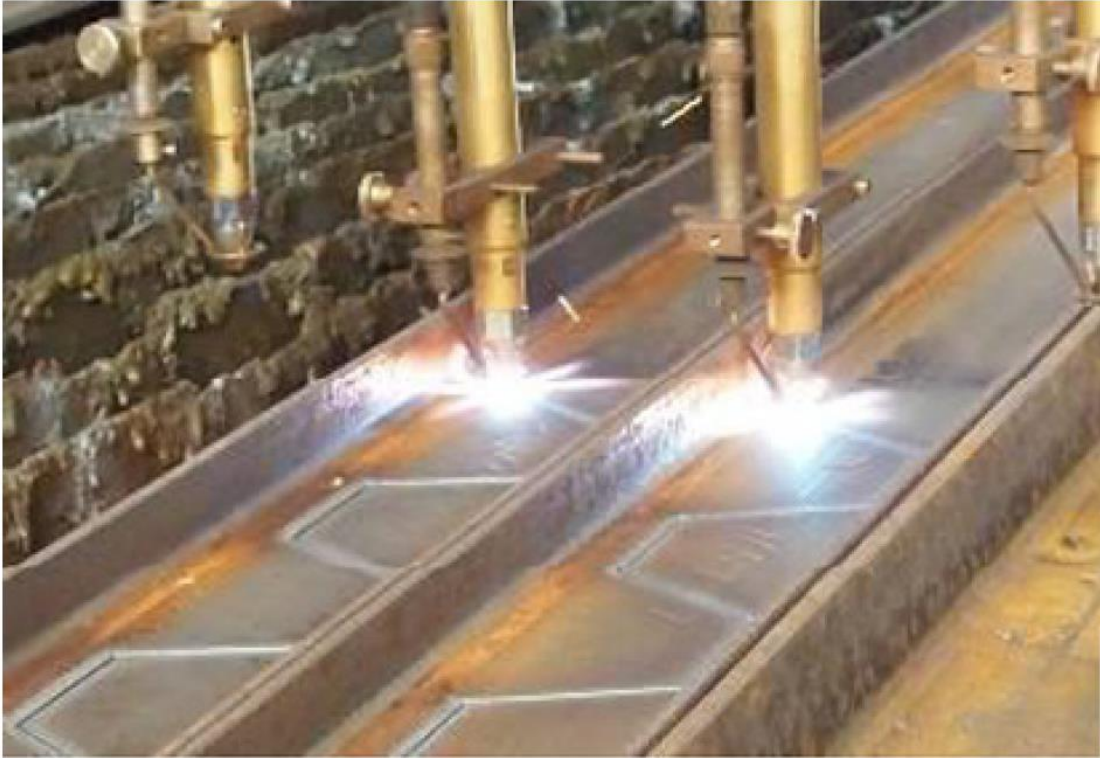
Figura 2.12 – Processo de Corte das almas das vigas casteladas
