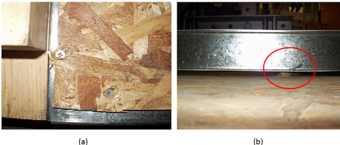
Figura 3.14 – Modos de falha nos parafusos do painel de LSF com placa OSB submetidos à carga horizontal
