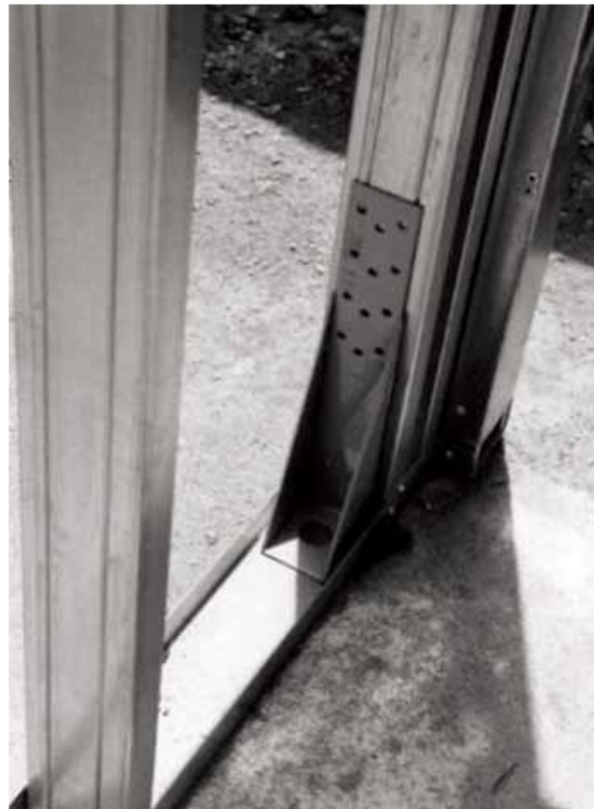
Figura 2.5 – Conector de ancoragem com barra roscada “hold-down”
