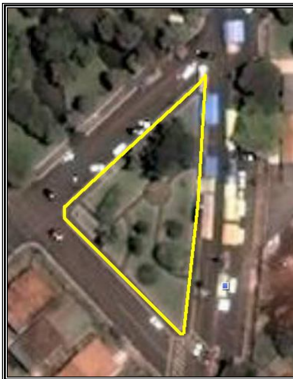
Figura 32 - Vista Aérea da Praça Paul Harris
