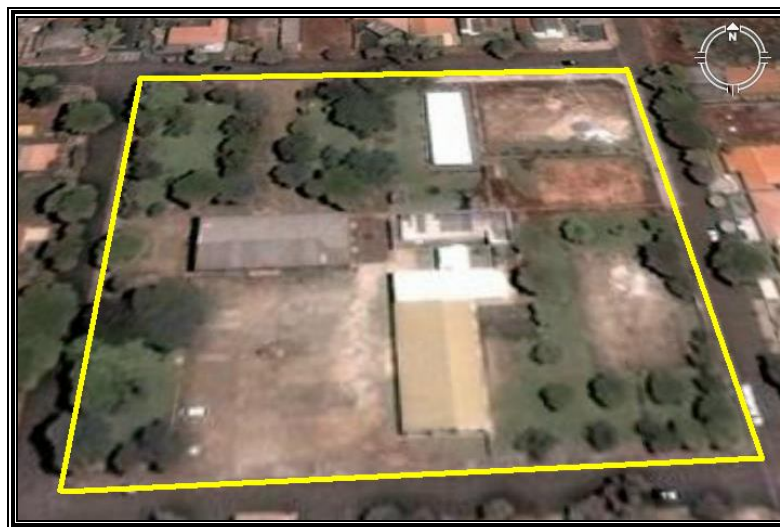
Figura 42 - Vista aérea da Praça Cônego Luiz Gonzaga Ribeiro
