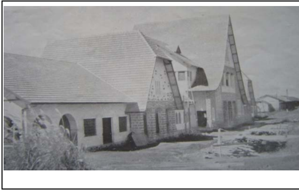
FIGURA 14 - Estação Ferroviária do Município de Londrina - Paraná
