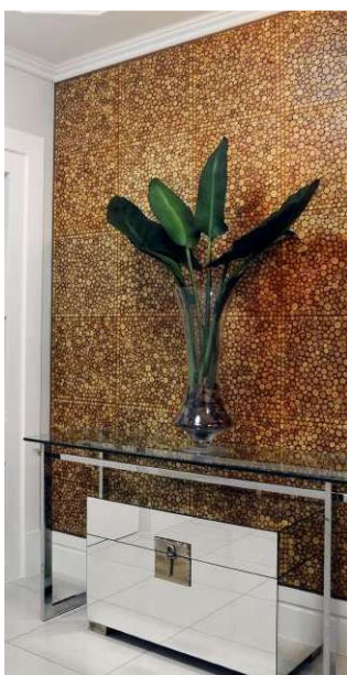
Figura 15 - Parede inteira revestida com madeira de poda de macieira Fonte: Seivarte, 2011
