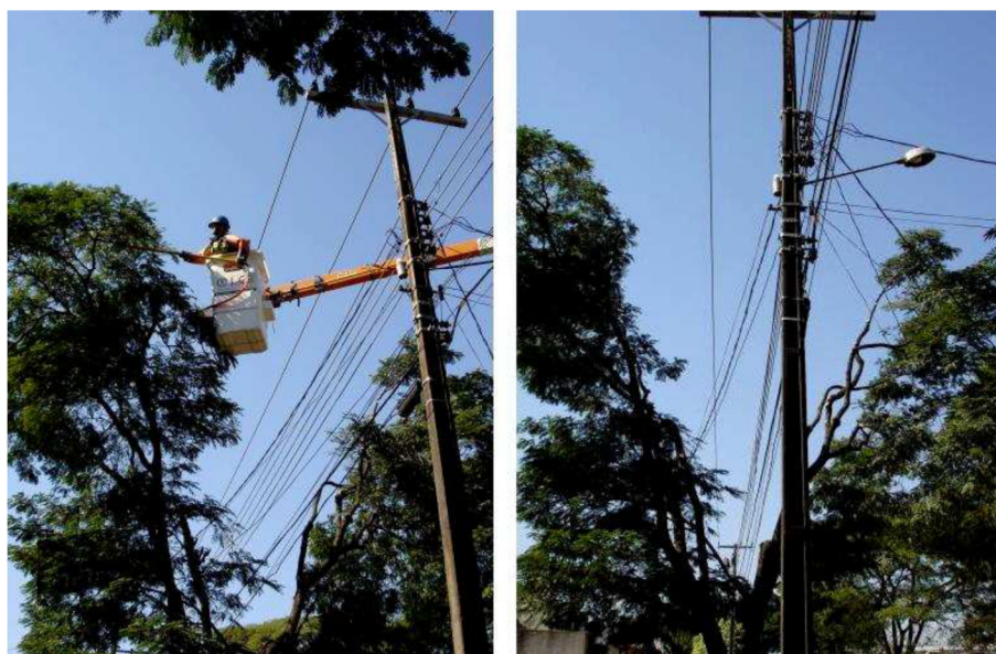
Figura 20 - Arborização durante e após a poda com o equipamento 3 em 1 Fonte: Copel, 2009
