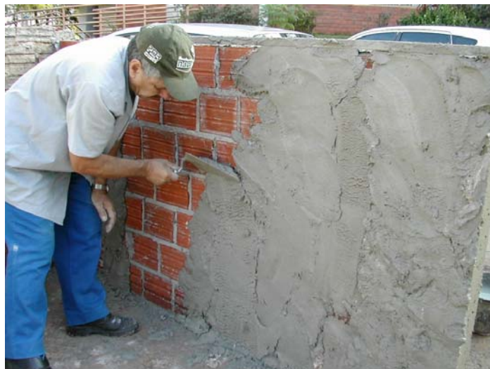
Figura 3.16 – Construção da parede experimental
