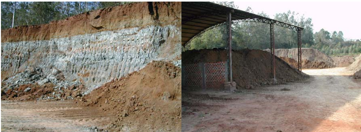
Figura 3.3 – Locais de extração da argila e de depósito para uso industrial.
