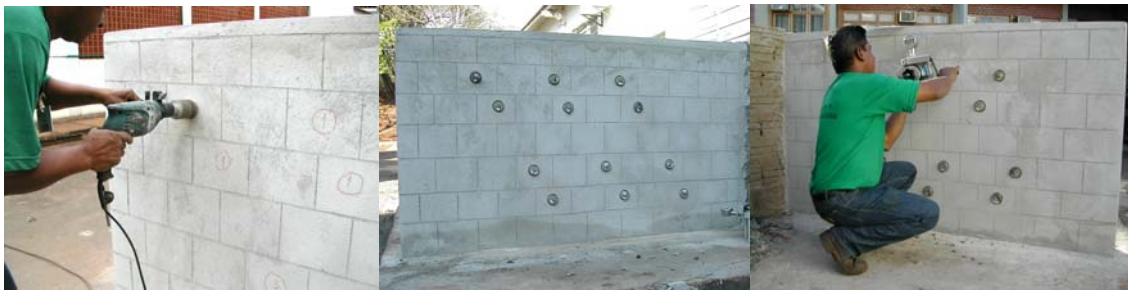
Figura 3.17 – Fixação das pastilhas para o teste de arrancamento de argamassa.
