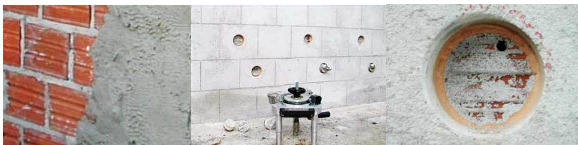
Figura 3.15 – Corpos-de-prova locados na parede experimental de alvenaria de blocos cerâmicos com revestimento de argamassa
