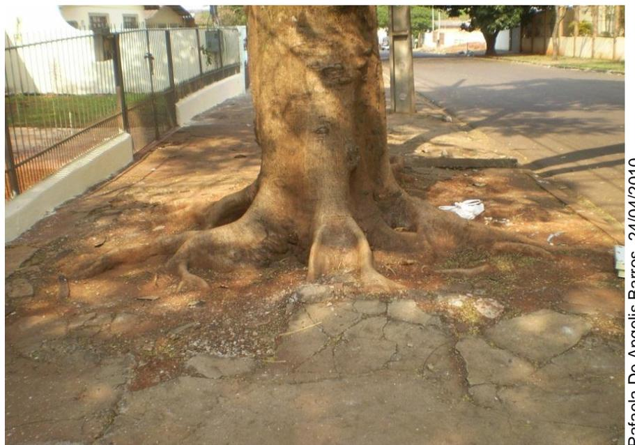
**Figura 9** – Calçada danificada pelo soerguimento das raízes em Maringá.
