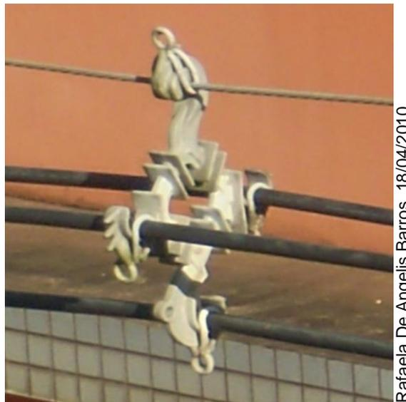
**Figura 10** – Detalhe do espaçador que sustenta três cabos de alta tensão.
