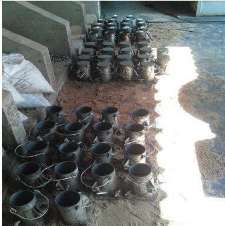
Figura 27 - Concretagem dos corpos-de-prova
