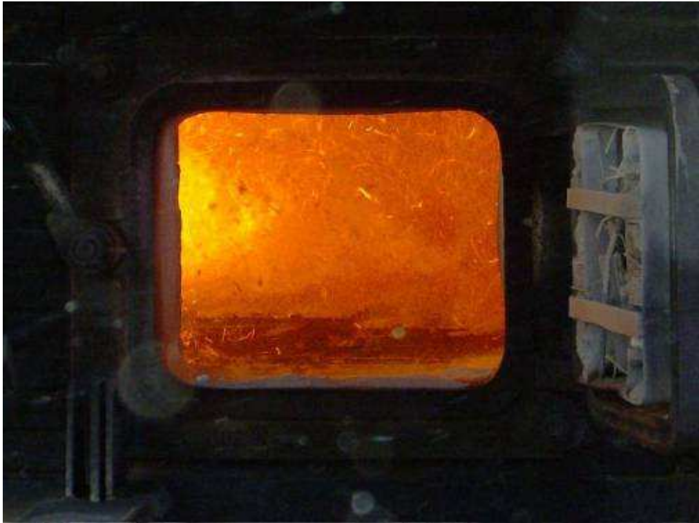
Figura 17 - Combustão do bagaço
