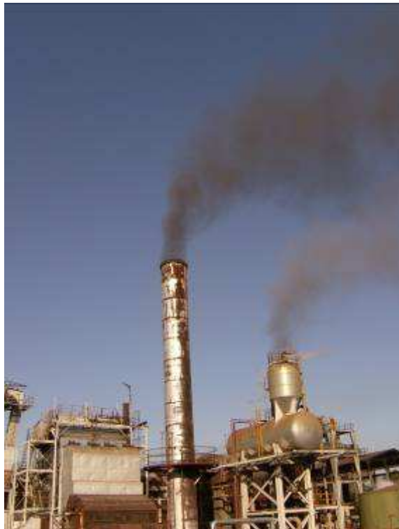
Figura 19 - Eliminação da cinza junto com os gases
