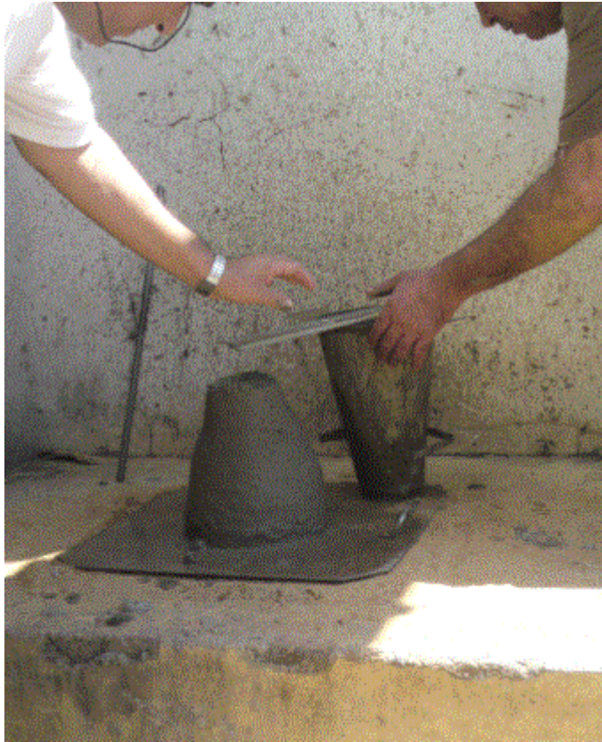
Figura 28 - Determinação de abatimento pelo método slump test
