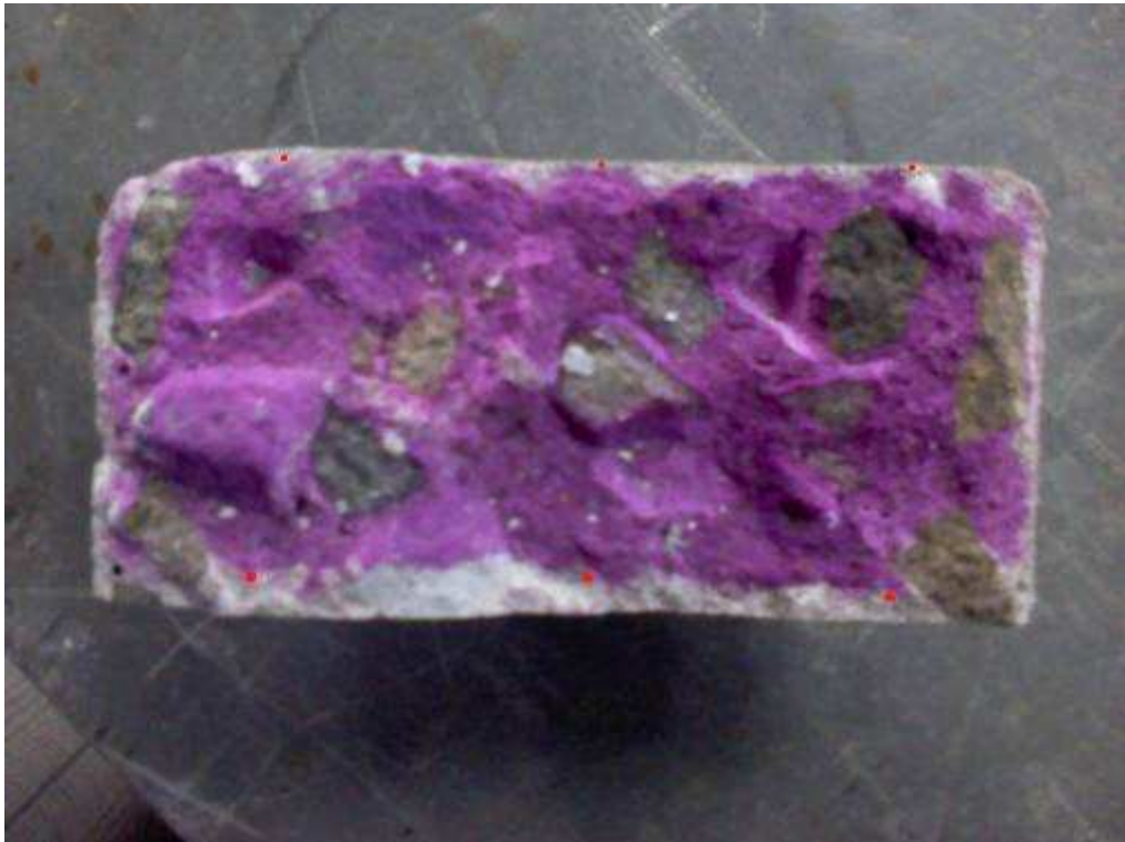
Figura 36 - Medida da frente de carbonatação
