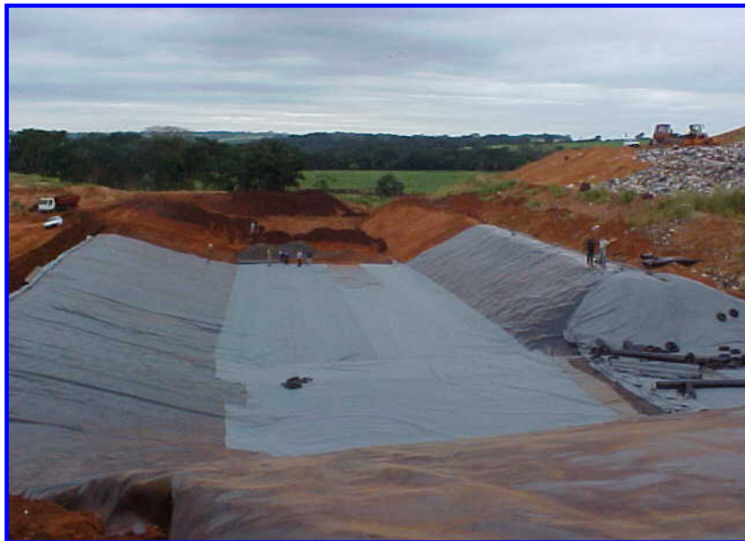
Figura 13 - Vala de um aterro sanitário
