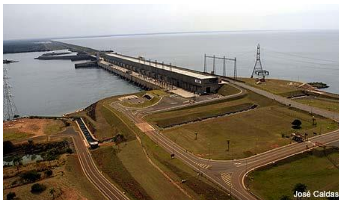
Figura 2: Usina Hidrelétrica Porto Primavera
