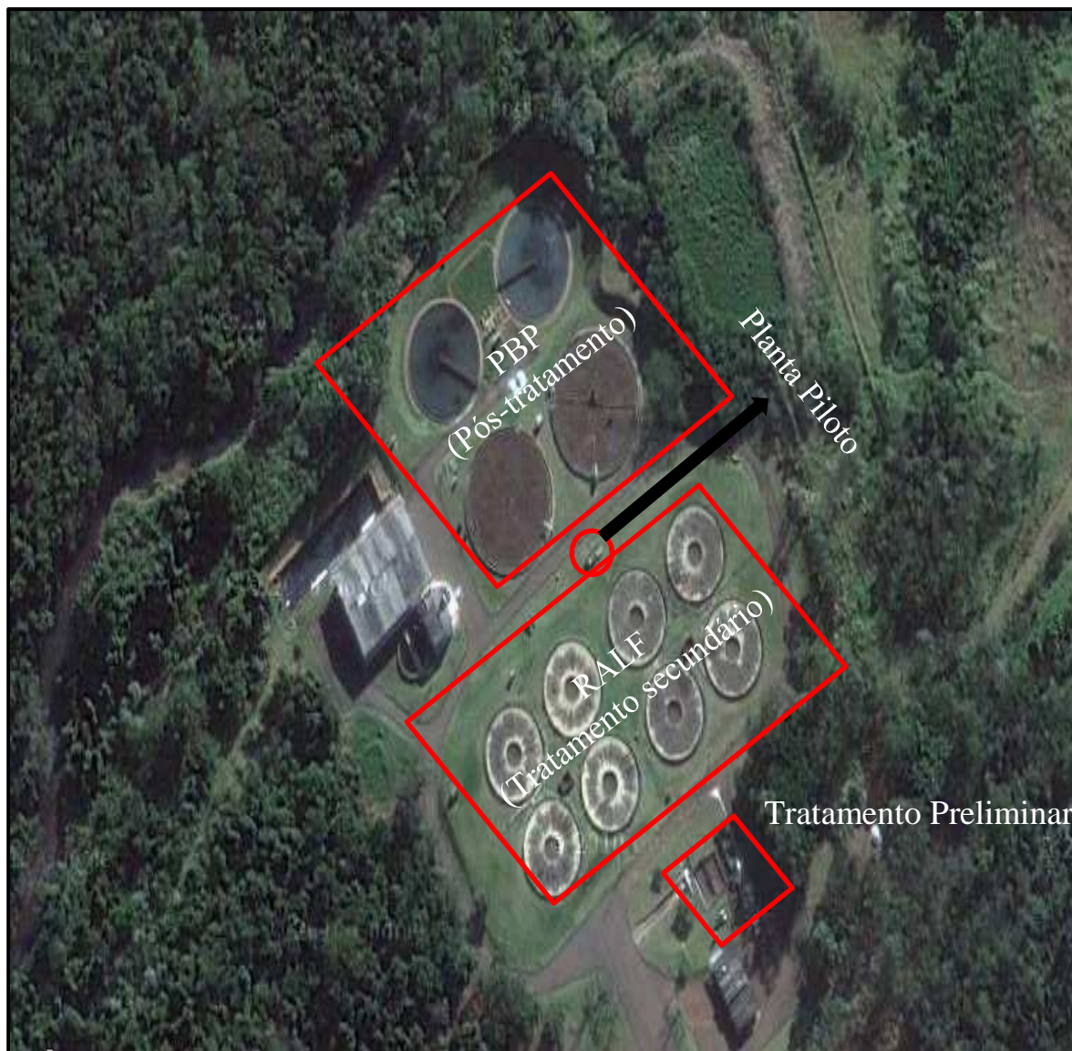
Figura 4.3- Localização da planta piloto na ETE
