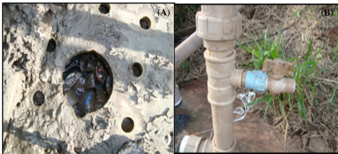
Figura 4.9- Pontos de coleta para análises microbiológicas. (A) Abertura na parte superior do reator; (B) Registro para a coleta do lodo de recirculação
