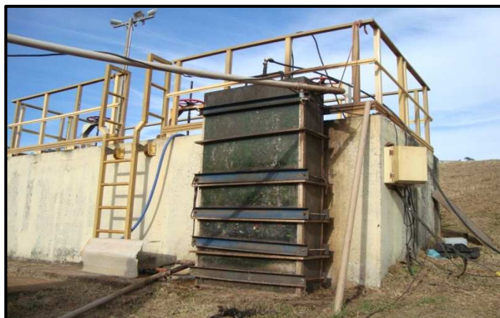
Figura 3.5- Filtro biológico aerado submerso (FBAS)
