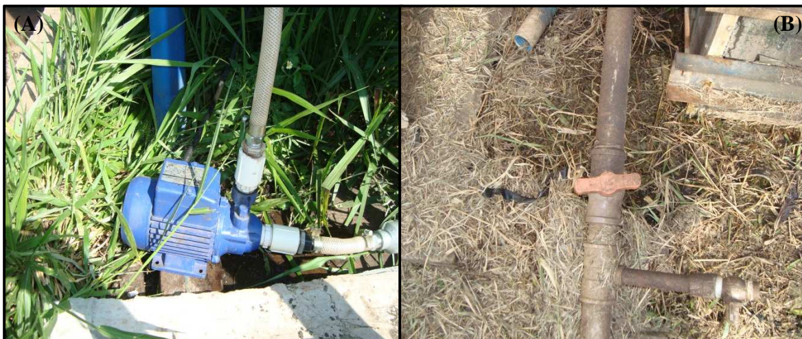
Figura 4.7- Sistema de recirculação da unidade experimental. (A) Bomba hidráulica responsável pelo recalque do lodo até a entrada do sistema; (B) Registro para o controle da vazão
