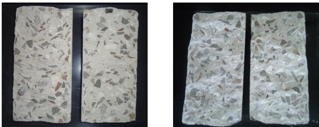
Figura 64 – Aspectos visuais dos concretos com e sem CBC
