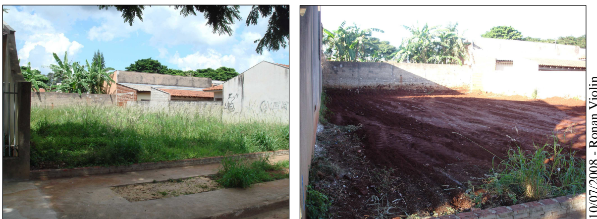
Figura 6.3.1 - Limpeza do terreno – Obra D
