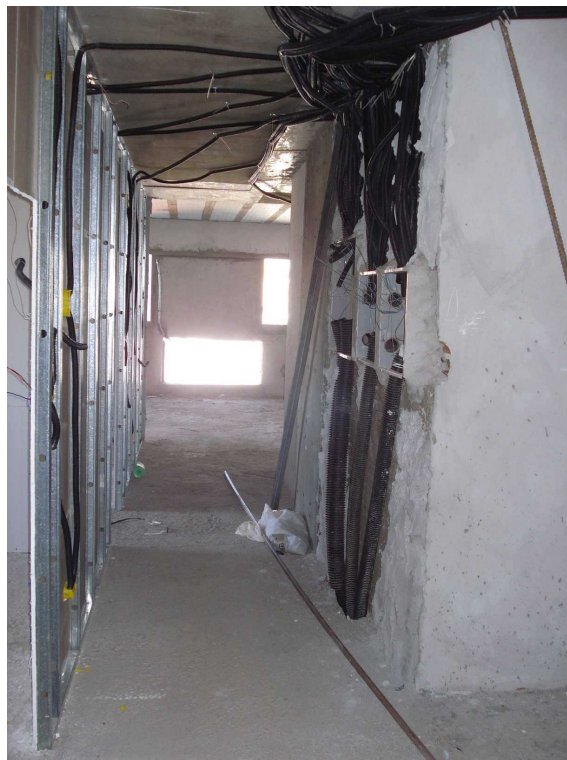
Figura 6.1.2 – Prumadas elétricas – Obra A
