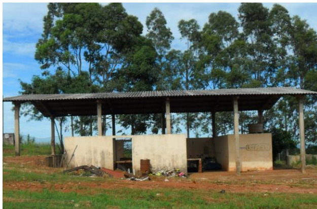
Figura 81 – Vista do Galpão de triagem de materiais recicláveis do município de Ângulo/PR
