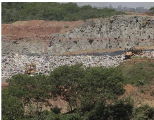
Figura 106 – Vista parcial da operação do aterro sanitário da Constroeste - Maringá/PR Fonte: PACHECO (2010)
