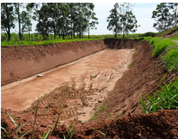
Figura 91 - Vala aberta aguardando aplicação de da manta de PEAD
