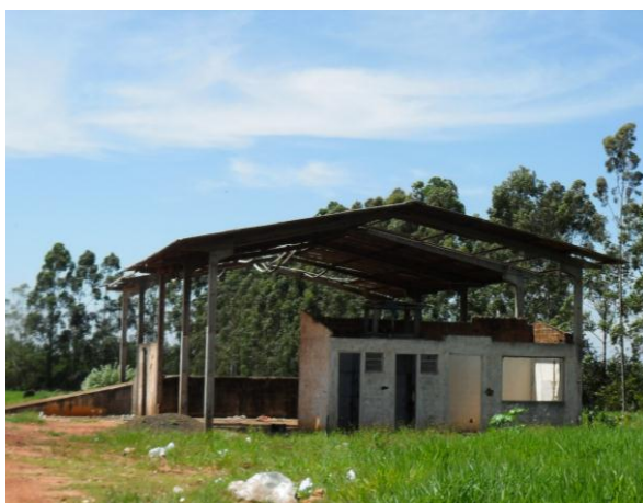
Figura 95 - Galpão para triagem construído em 1998 – Mandaguaçu.
