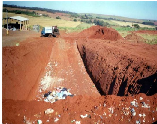
Figura 84 – Primeira vala aberta no aterro de Astorga em 2001.
