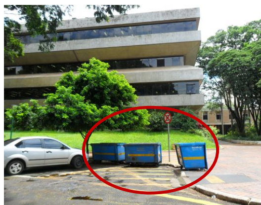
Figura 17 – Contêiner instalado ao lado do prédio da Prefeitura de Maringá/PR.
