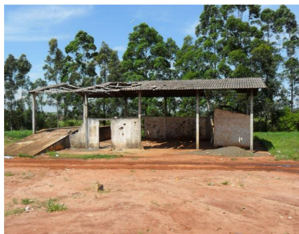
Figura 96 - Vista lateral do galpão de triagem - Mandaguaçu.
