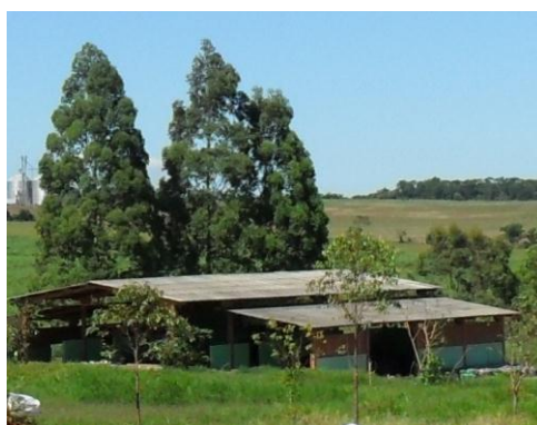
Figura 90 – Vista Galpão de triagem em 2010 – Astorga/PR.
