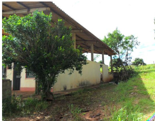
Figura 82 – Vista da lateral esquerda do Galpão de Triagem – Ângulo/PR.
