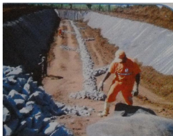
Figura 92 - Execução do sistema de drenagem do lixiviado após aplicação da manta de PEAD
