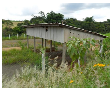
Figura 62 – Vista parcial do PEV Jardim Diamante – Maringá/PR.
