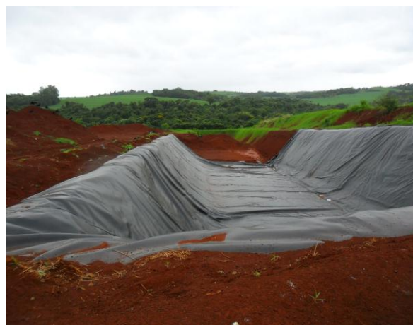
Figura 98 - Vista de vala com aplicação de manta de PEAD – Marialva/PR.
