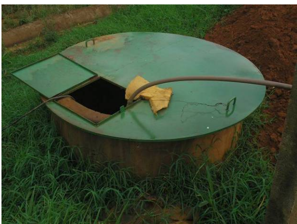
Figura 74. Local de armazenagem do líquido captado do aterro em vala de Tapejara/PR
