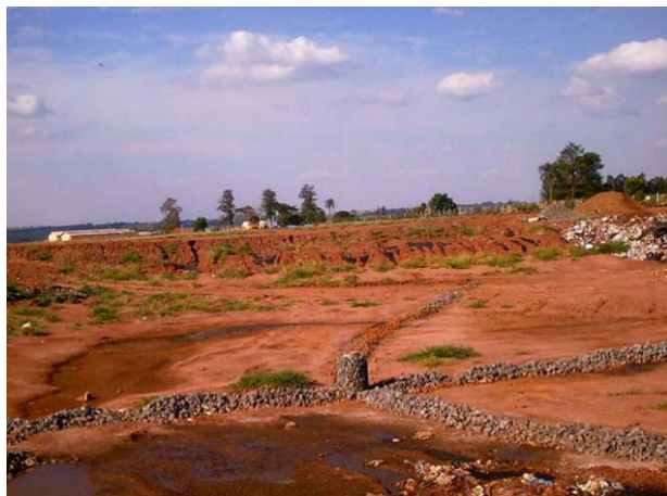
Figura 64. Abertura da primeira célula do aterro sanitário de Cianorte em 2003 Fonte: Ramos (2004)
