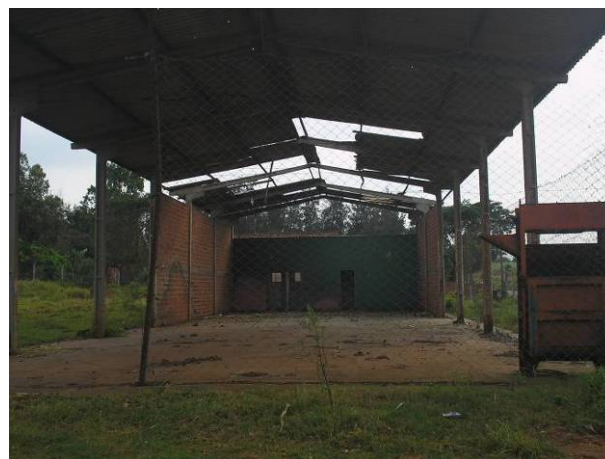
Figura 52. Barracão desativado para acondicionamento de recicláveis em Tapejara/PR
