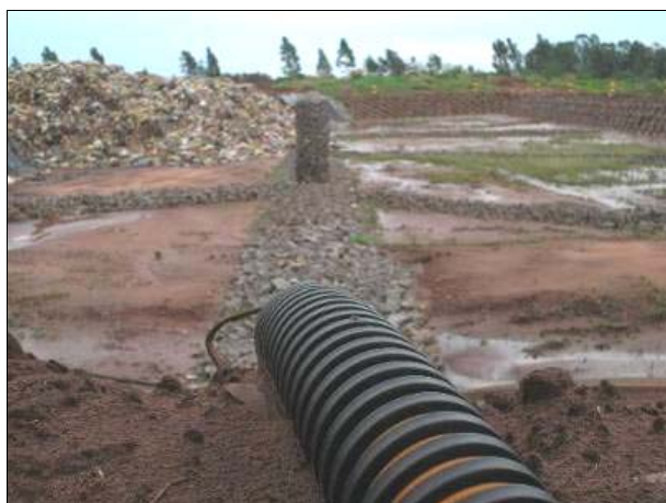
Figura 68. Sistema de drenagem de líquidos percolados do aterro sanitário de Cianorte/PR Fonte: Albertin et al. (2009).
