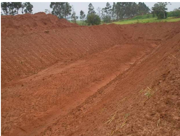
Figura 72. Abertura de nova célula do aterro sanitário em vala de Tapejara/PR
