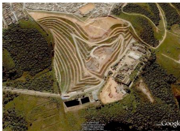
Figura 25. Aterro Sanitário de Santo André/SP
