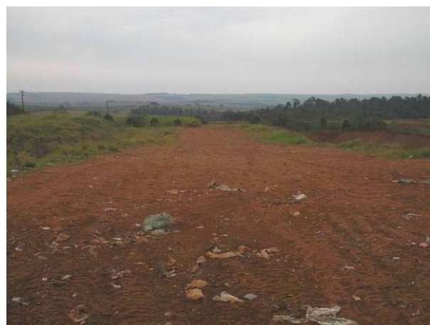
Figura 75. Célula aterrada de resíduos sólidos e ausência de drenos de gases no aterro em vala de Tapejara/PR
