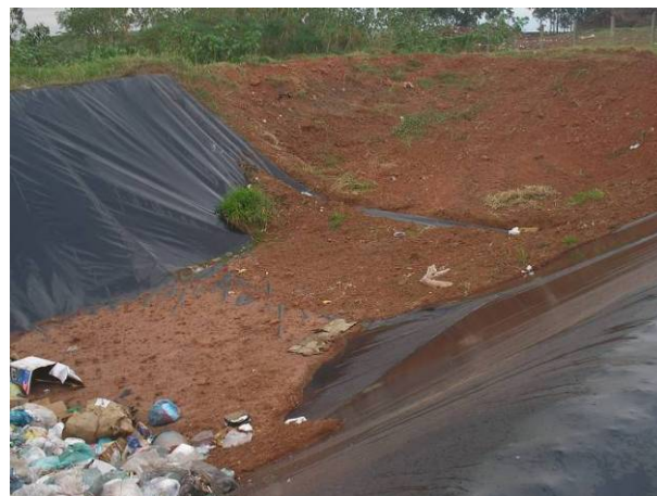
Figura 73. Vista parcial da geomembrana do aterro sanitário em vala de Tapejara/PR
