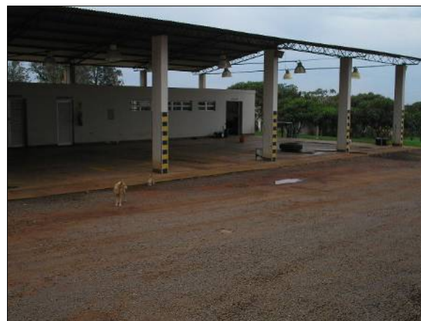
Figura 71. Área para abrigo de veículos e equipamentos no aterro sanitário de Cianorte/PR
