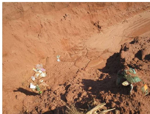
Figura 81. Abertura de vala para disposição de resíduos no aterro controlado em Indianópolis/PR
