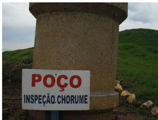
Figura 69. Identificação do poço de inspeção de lixiviado do aterro sanitário de Cianorte/PR
