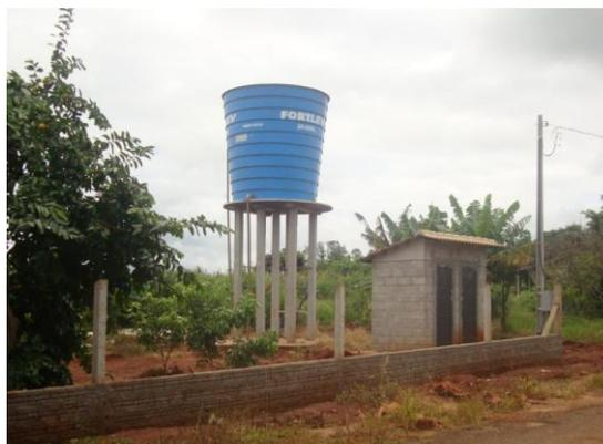
**Figura 4.12** - Novo reservatório de água, poço artesiano e casa de máquina.
