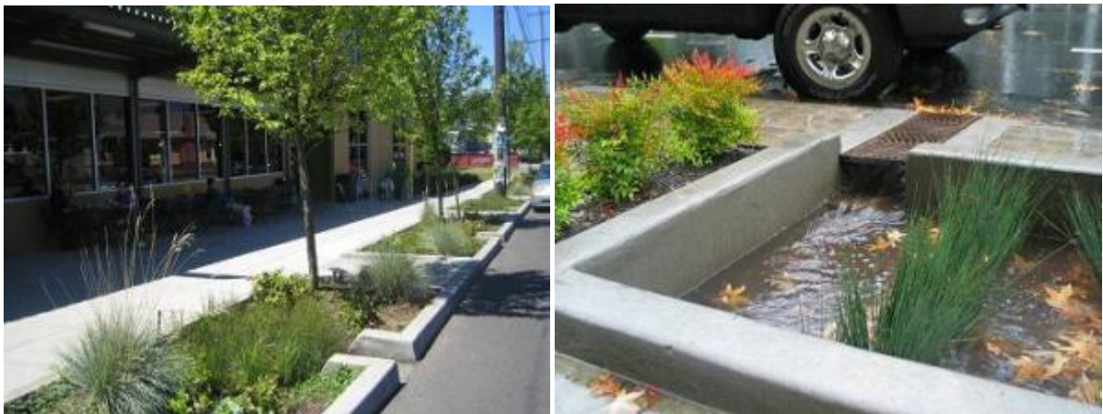
Figura 14 – Exemplo de canteiro pluvial
