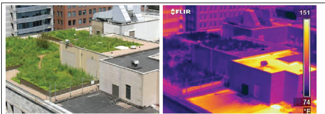
Figura 13 - Telhado da prefeitura de Chicago, e a relação das temperaturas com os diversos elementos presentes nessa estrutura.
