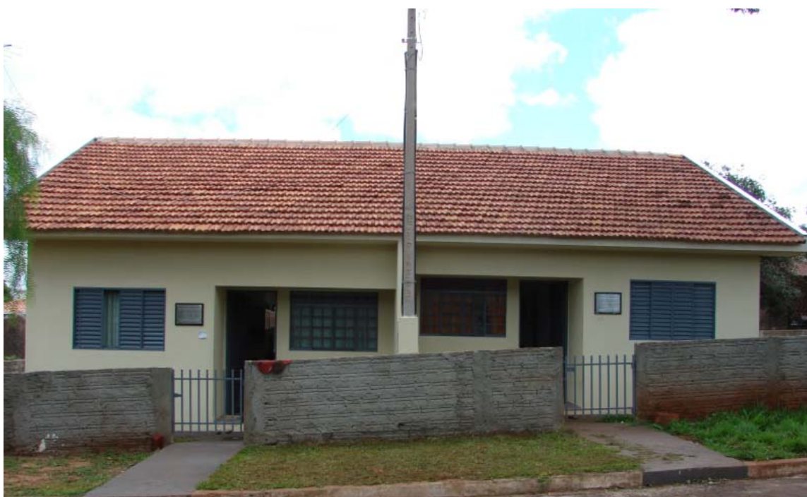
Figura 5.11 Unidade acabada em alvenaria nova 2 – 4ª fase
