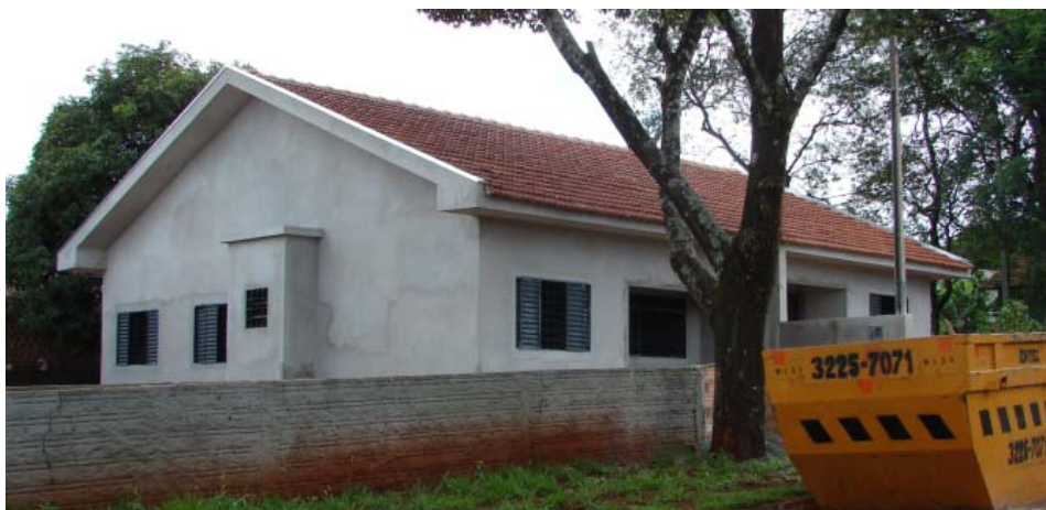
Figura 5.12 Unidade em construção em alvenaria nova 2 – 4ª fase
