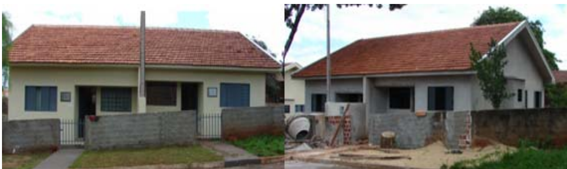
Figura 4.12 Vista das unidades da quarta fase: alvenaria nova 2
