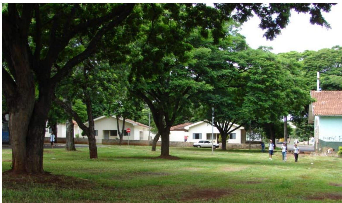
Figura 4.11 Vista das unidades da terceira fase: alvenaria nova 1
