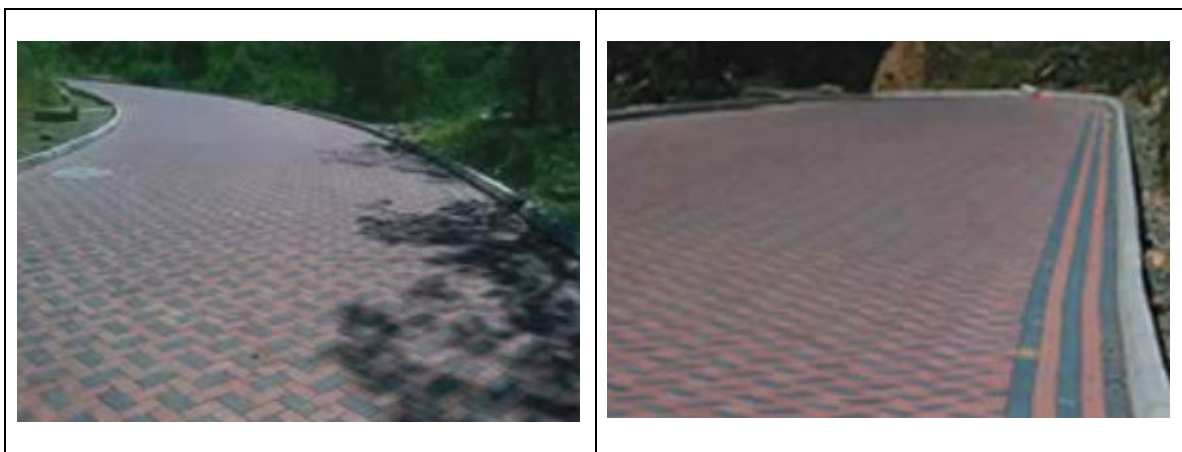
Figura 2.6 – Rodovia construída com BCP na Colômbia
