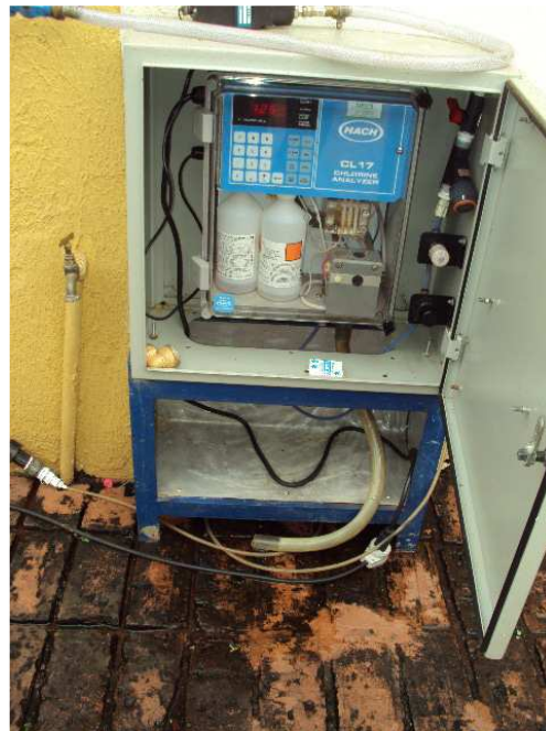
Figura 13 - Analisador de cloro utilizado
