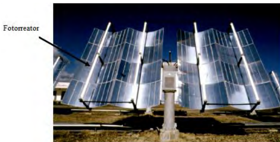
Figura 2. 9. Coletor Cilíndrico Parabólico (PTR) instalado na Plataforma Solar de Almería.
