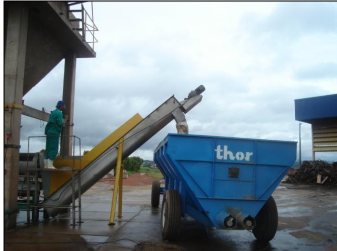
Figura V.1 – Carreta de transporte de material para a caldeira.
