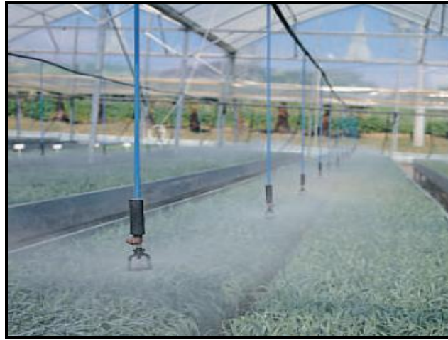
Figura V.4 – Modelo de nebulizadores instalados no curral. Figura apenas ilustrativa.
