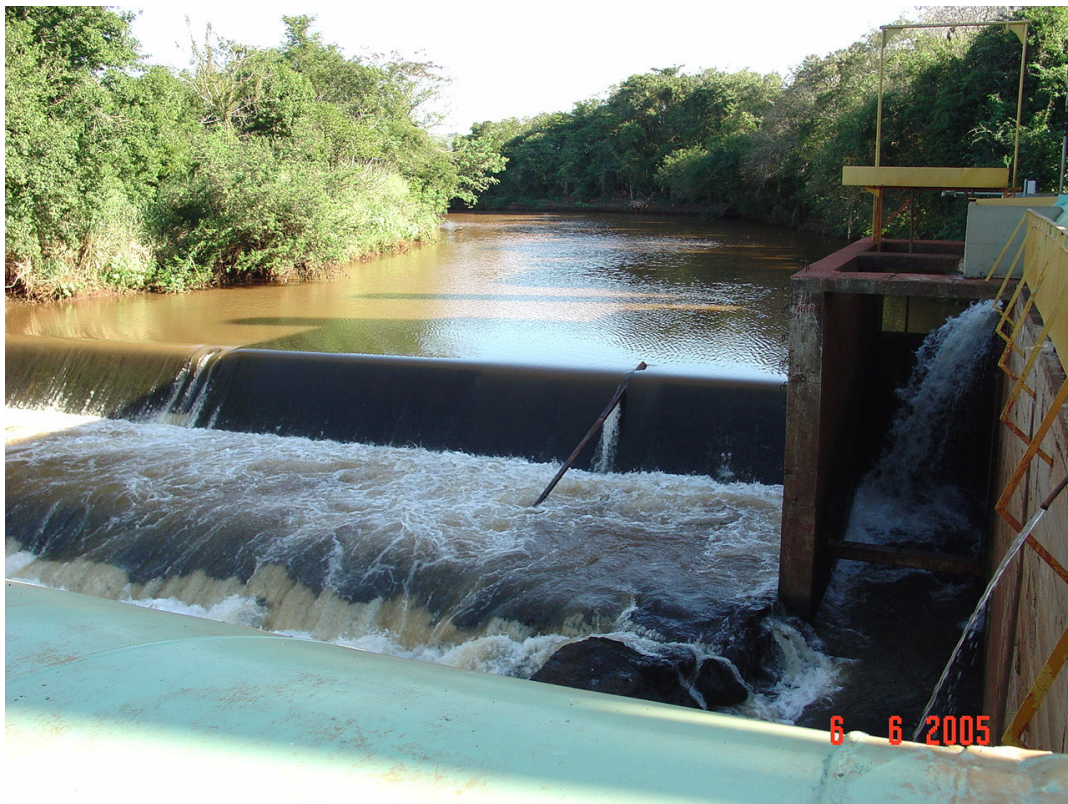
Figura 4.1 - Vista do ponto de captação de água da cidade de Maringá
