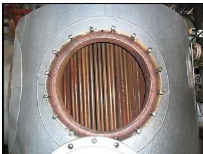
Figura 5.3 Parte interna do evaporador
