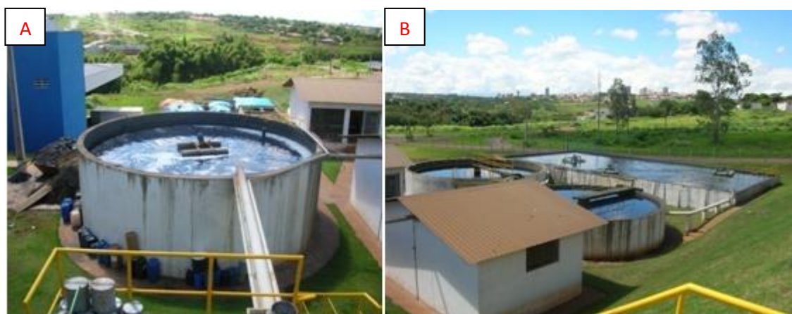
Figura 8. (A) Lagoa de equalização e (B) Lagoa tratamento biológico (autor).
