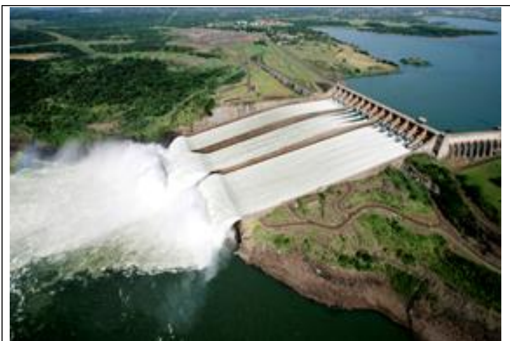
FIGURA 13 – Vertedouro da Usina Hidrelétrica de Itaipu, Foz do Iguaçu FONTE: Acervo da Paraná Turismo
