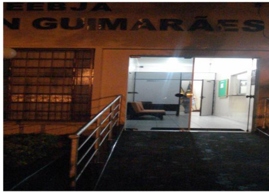
Fig. 5 – rampa de entrada com textura e corrimão
