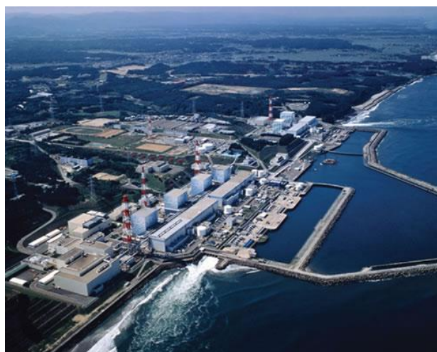
Figura 13: Vista aérea da usina nuclear de Fukushima I e do quebra-mar, antes de 11/03/2011.
