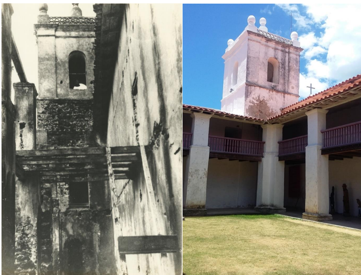
Figura 24: Corredor avarandado, em ruínas 1945, restaurado 2015, Igreja e Residência dos Reis Magos, Nova Almeida.
