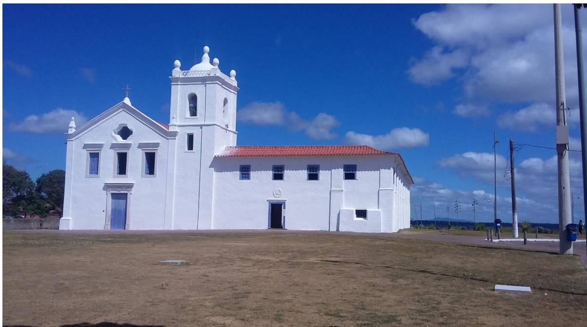
Figura 36: Fachada principal da Igreja e Residência dos Reis Magos, Nova Almeida, 2015. Fonte: Arquivo pessoal da autora.
