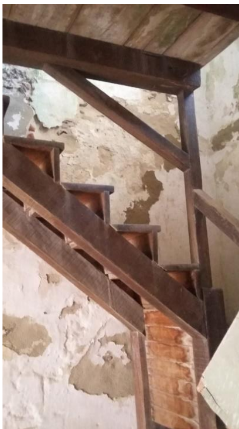
Figura 39: Escada para acesso à Torre dos Sinos, Igreja dos Reis Magos, Nova Almeida, 2015. Fonte: Arquivo fotográfico da autora.
