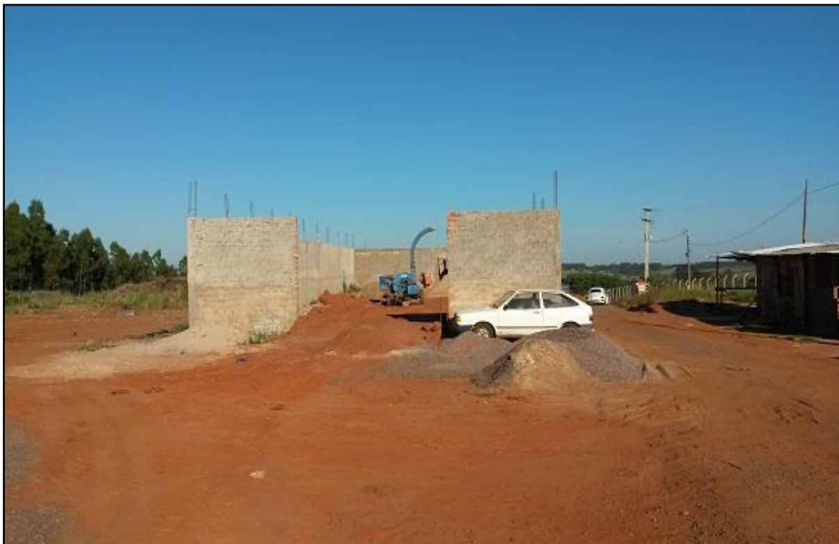
Foto 16 – Construção do barracão destinado à central de triagem em Pirapozinho - SP
