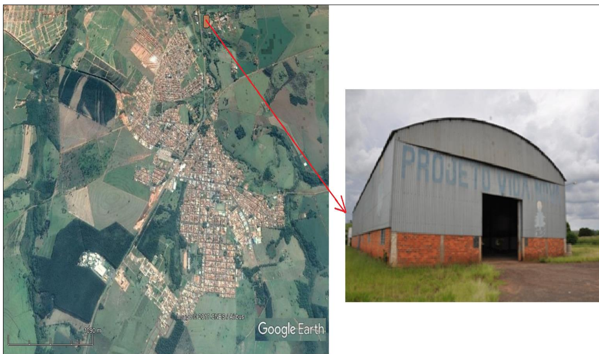
Figura 3 – Localização da central de triagem de resíduos sólidos recicláveis de Itaipó - SP
