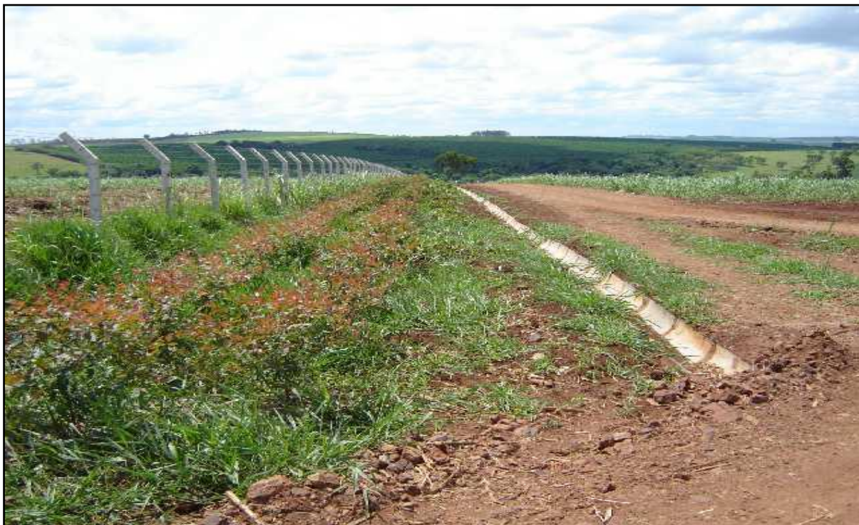
Foto 7 – Drenagem lateral do aterro controlado de Itaip - SP em 2011
