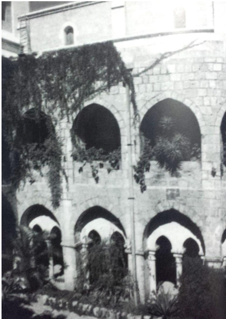
Figura 1 - Os claustros da antiga abadia de Santa Maria dos Latinos 12
