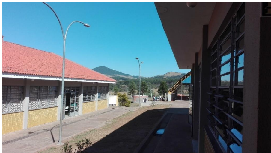
Figura 16: Prédio novo onde funcionam as Escolas do campo
