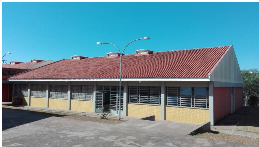
Figura 18: Prédio novo onde funcionam as Escolas do campo
