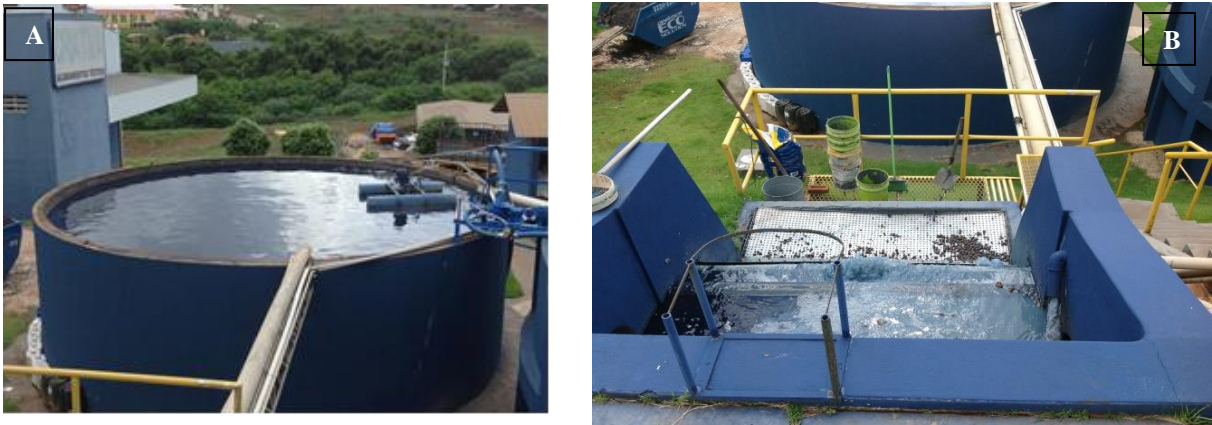
Figura 9. Estação de tratamento da ETE da lavanderia industrial: (a) lagoa de equalização e (b) peneira estática.
