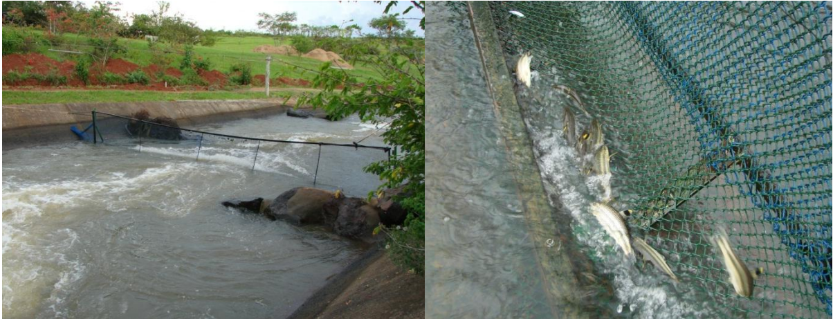
Figura 2. Estrutura de contenção içada (esquerda) e peixes retidos (direita) quando interrompido o fluxo de água no Canal de Águas Bravas.
