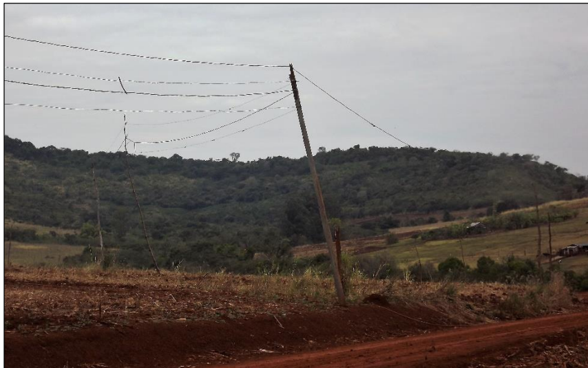
Figura 44: Rede elétrica construída pelos camponeses na área Fonte: Aline Albuquerque Jorge, 30-11-2017
