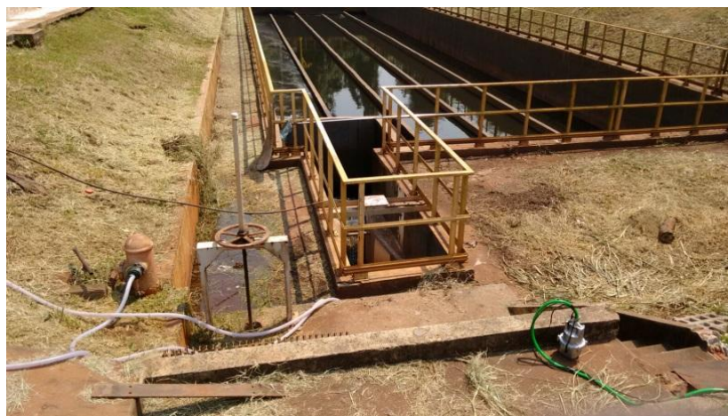
Figura 4. Lagoa de decantação do sistema de tratamento da ETE-SUL, Maringá-PR.
