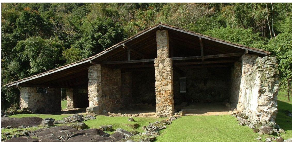
Figura 25. Ruínas Engenho São Jorge dos Erasmos. Destaque para a cobertura.
