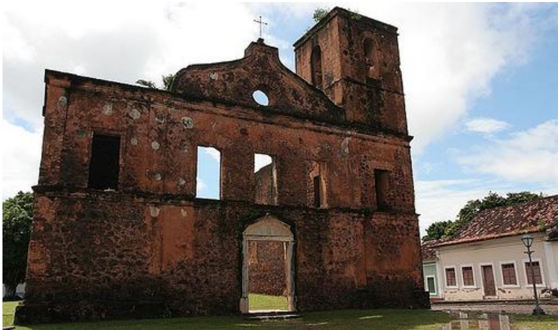
Figura 4. Ruínas da Igreja Matriz. Alcântara, MA.
