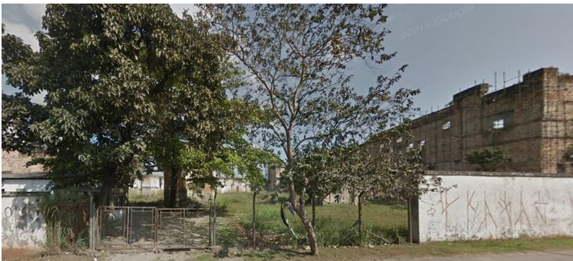
Figura 46. Abertura do pátio interno para a Av. Perimetral. Em frente ao Porto de Santos.
