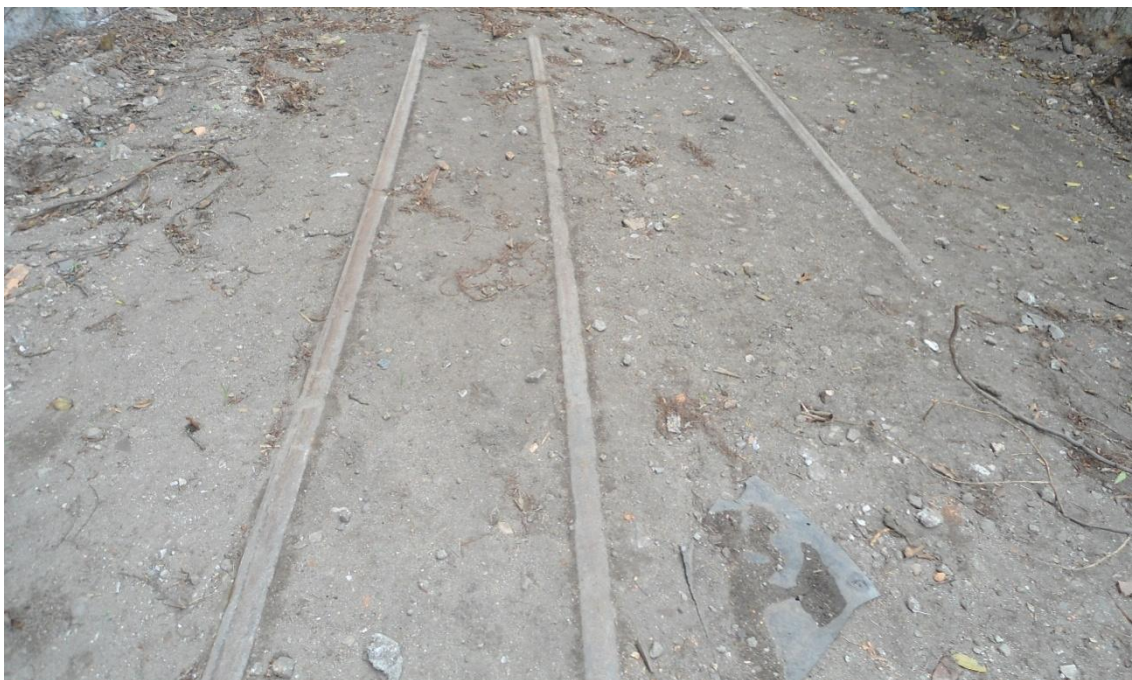
Figura 40. Remanescentes dos trilhos no pátio.
