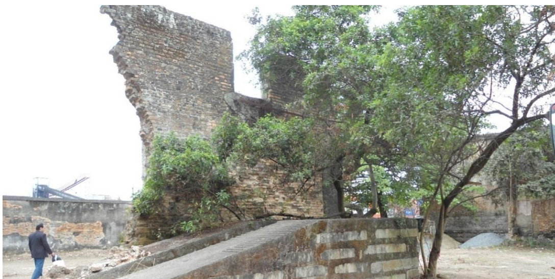
Figura 41. Parte de um muro e plataforma elevada.
