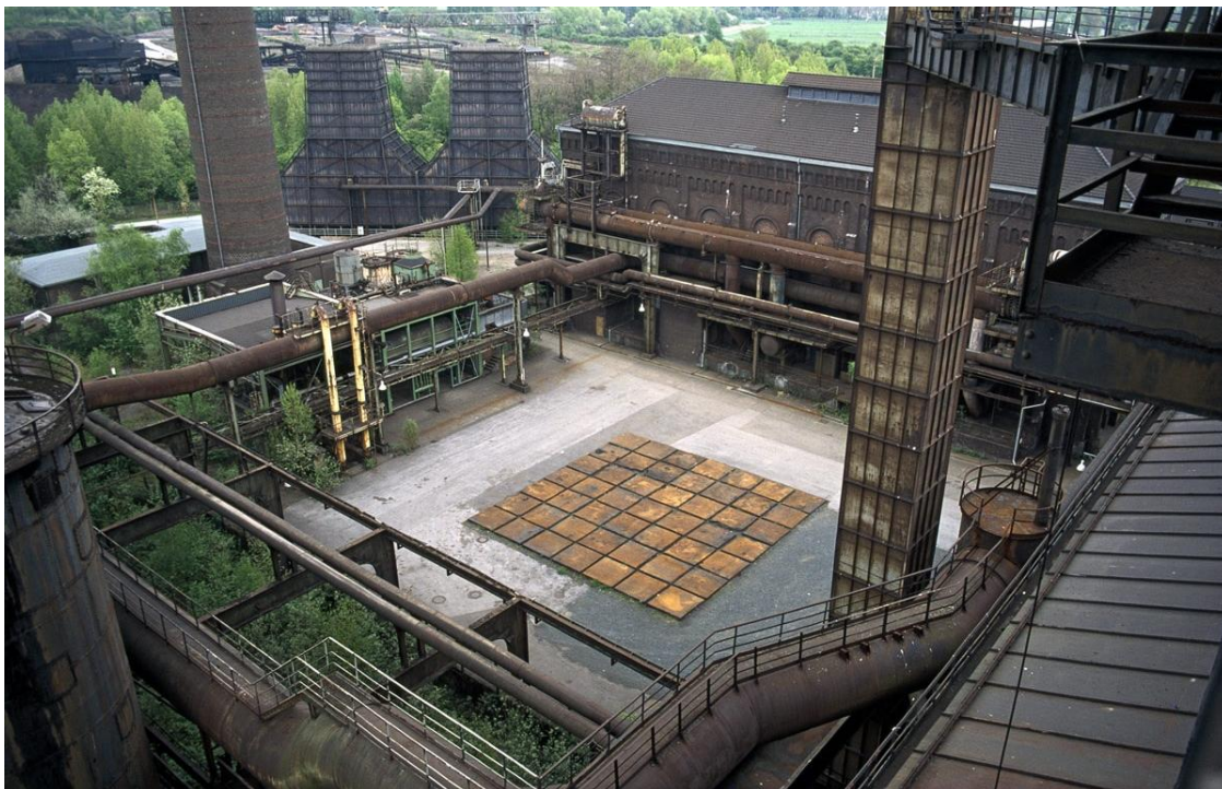
Figura 28. Piazza Metallica. Detalhe para as placas de ferro utilizadas para compor o piso. Fonte: LATZ und Partner 81 , s/d.
