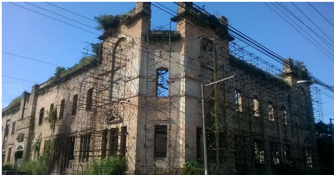
Figura 36. Alvenaria aparente nas fachadas da ala norte da Hospedaria. Foto da autora, 2016.
