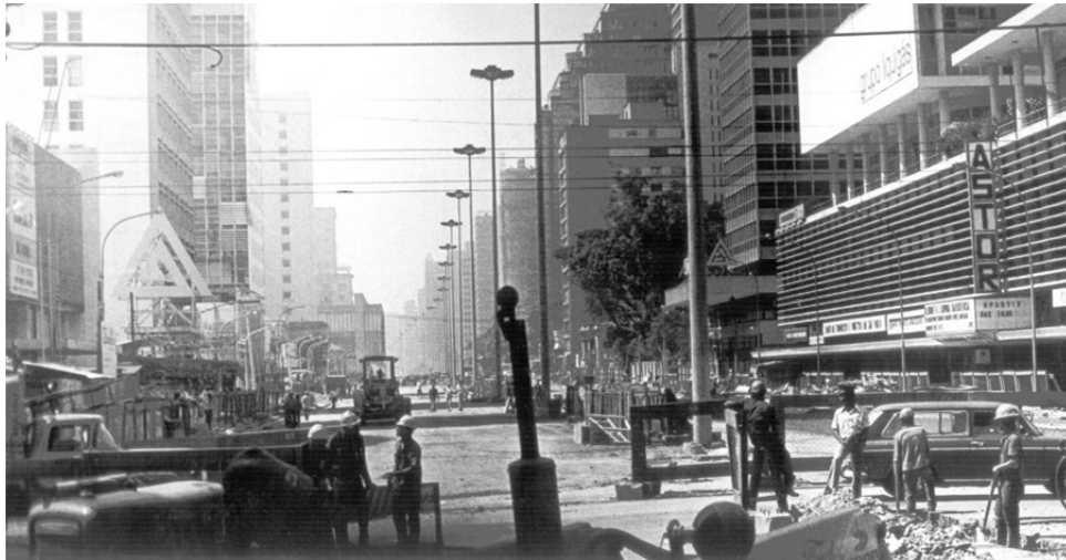
Figura 50: Obras de execução do projeto da “Nova Paulista”(1972) – trecho em frente ao terreno do Banco Safra.
