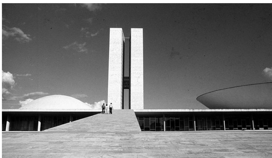
Figura 23: Edifício do congresso nacional (1958) – Oscar Niemeyer Fonte: Acervo Fundação Oscar Niemeyer.
