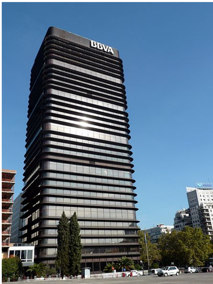
Figura 32: Edifício do Banco de Bilbao em Madri (1972) – Javier Saénz de Oíza Fonte: http://archist.blogspot.com.br/2015/06/torre-del-banco-bilbao-en-madrid-saenz.html .
