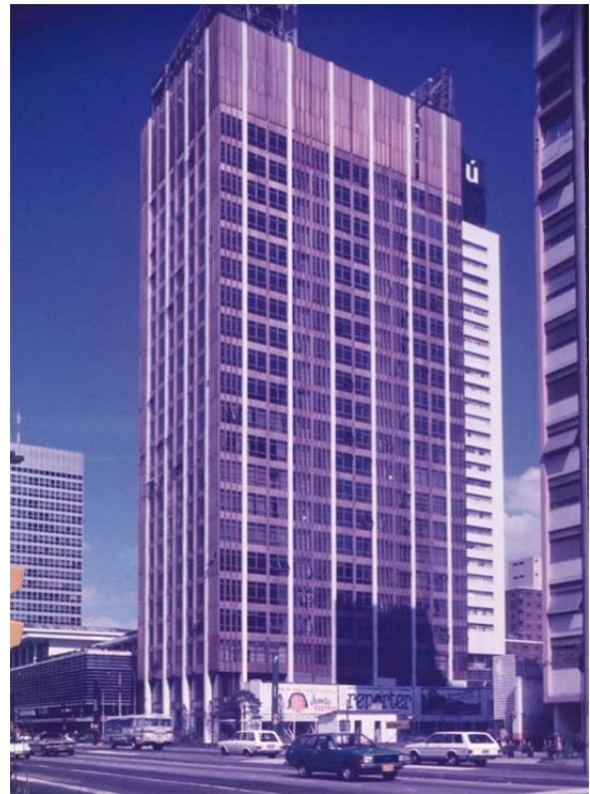
Figura 62: Edifício Ansarah Fonte: Foto de Hugo Segawa. http://www.arquigrafia.org.br .
