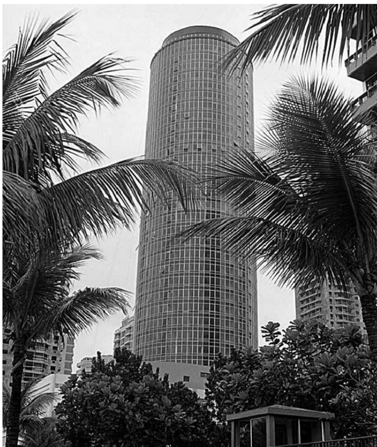
Figura 44: Edifício Centro Barra |Athaydeville (1969) – Oscar Niemeyer
