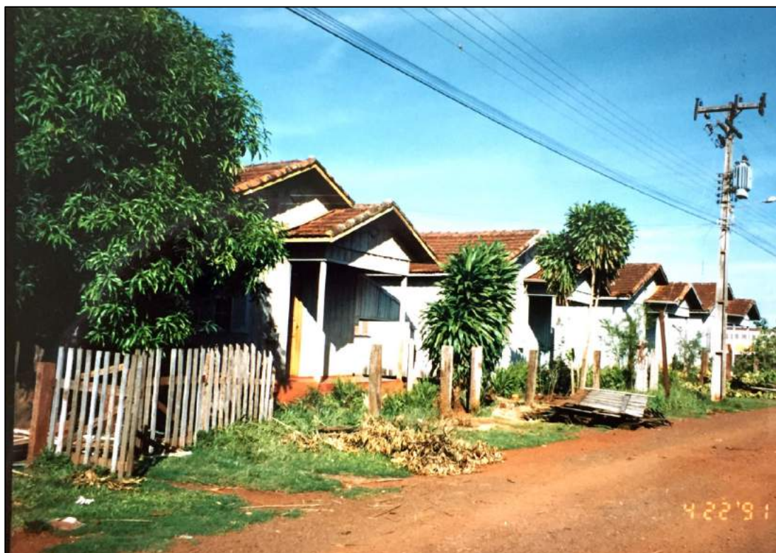
Figura 66: Residências dos ferroviários no ano de 1991, antes da demolição
