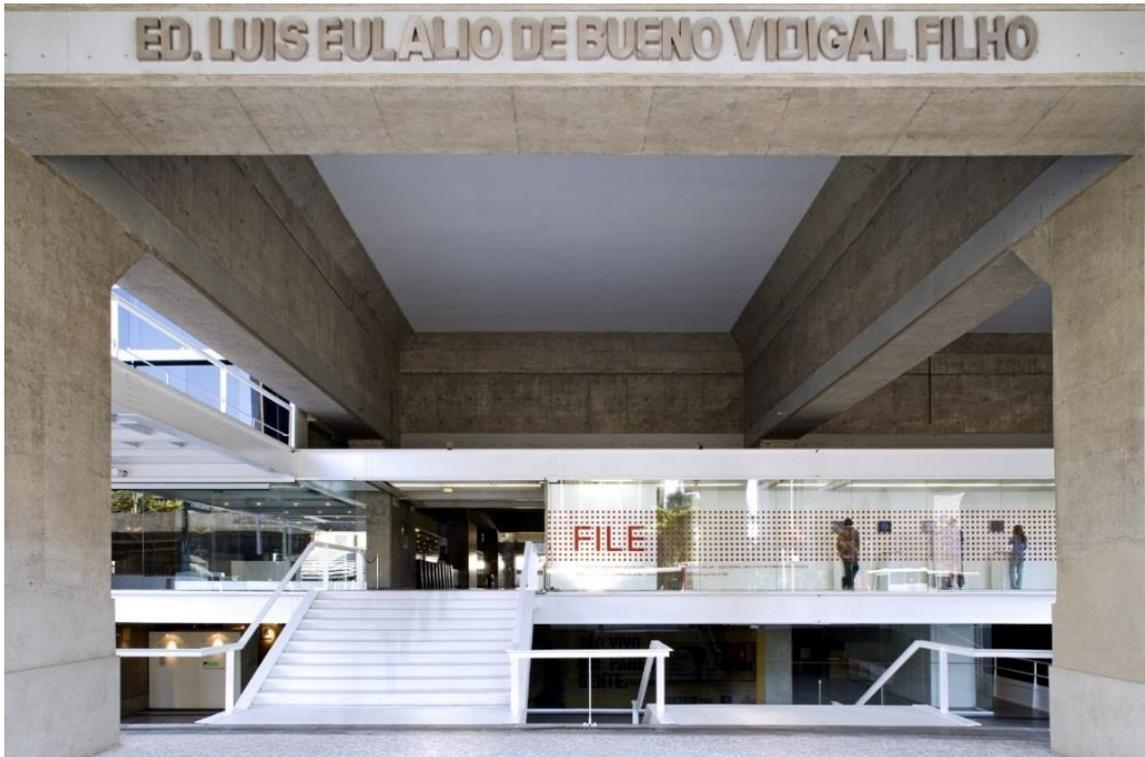
Figura 19 - Recorte na laje do pavimento superior - criação de um átrio junto à Avenida Paulista
