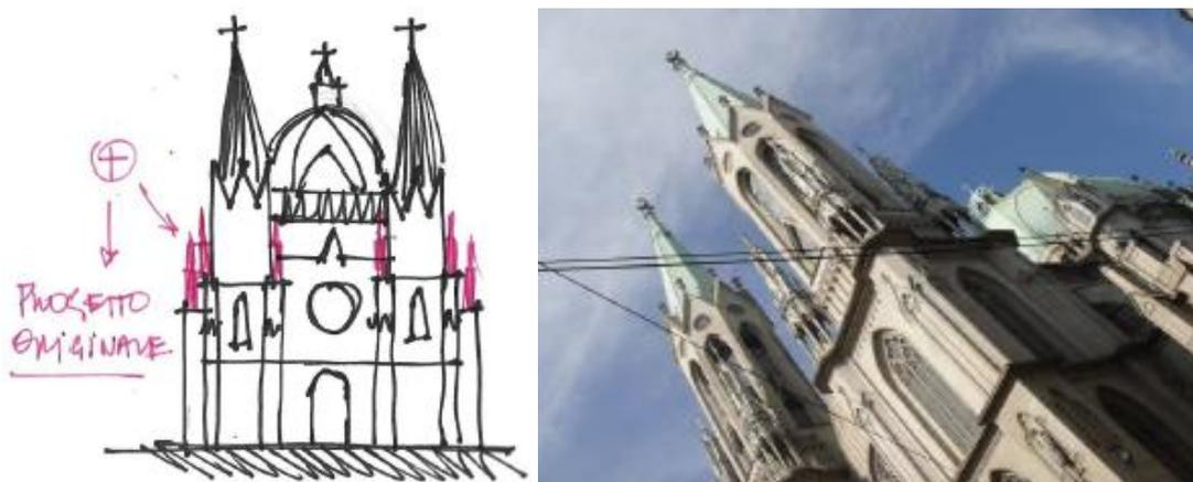
Figura 6 - Destaque para os torrões e agulhas novos executados segundo o projeto original
