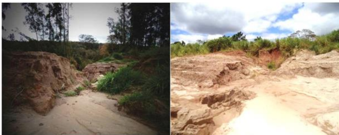
Figura 27 - Processos erosivos em uma porção da sub-bacia de número 10 – Bacia do Córrego Coruja próximo a área urbana de Cianorte/PR..
