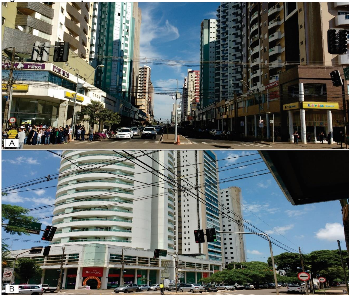
Figura 21 - Edificações na área de estudo
