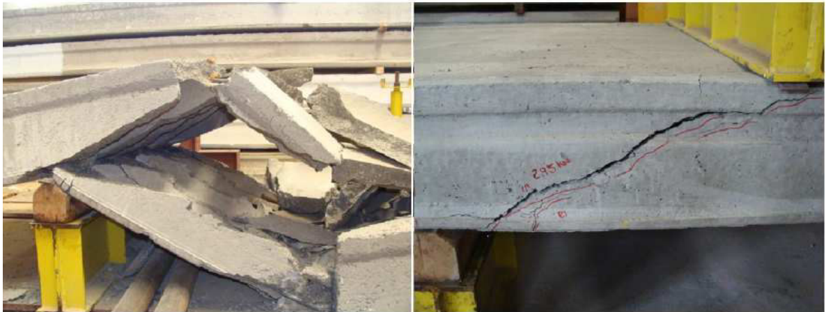
Figura 2.16: Rupturas por tração diagonal em lajes alveolares
