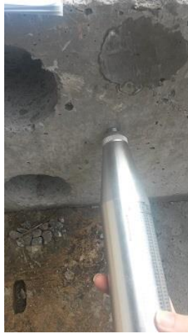
Figura 3.15 – Realização do ensaio esclerométrico no bloco de concreto
