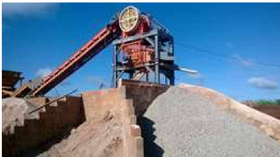
Figura 38 – Processo de beneficiamento do RCC em Usina
