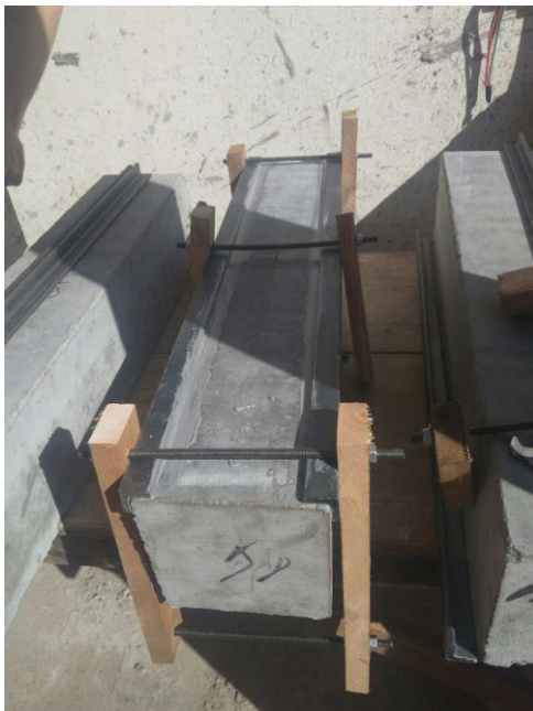
c) Instalação das abraçadeiras
