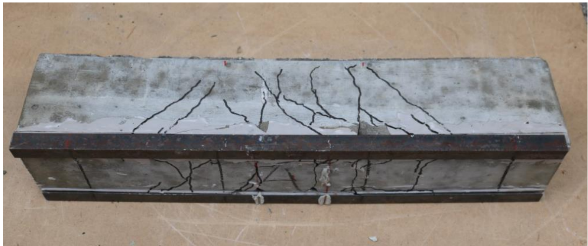
Figura 6.18 – Fissuras da Viga B1
