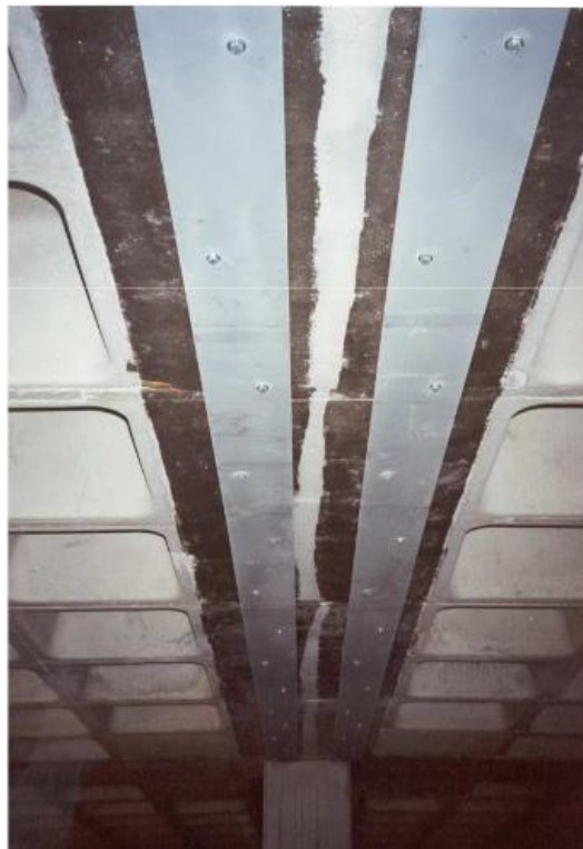
Figura 2.10 – Reforço de viga com chapas metálicas aderidas com resina e chumbador
