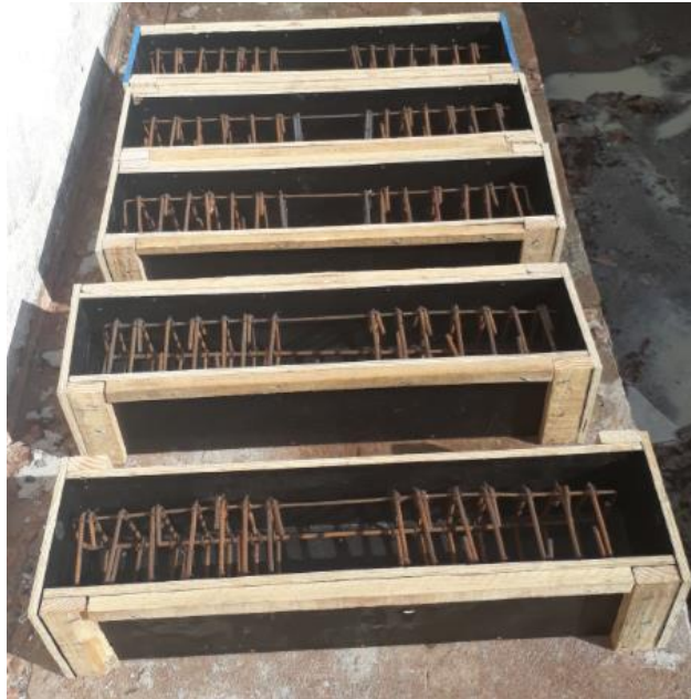
Figura 6.3 – Armaduras e formas
