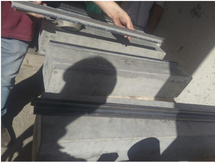
a) Aplicação do adesivo epóxi
