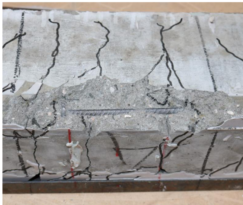
Figura 6.20 – Armadura interna exposta da Viga B1
