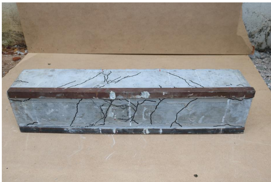
Figura 6.24 – Fissuras viga C3
