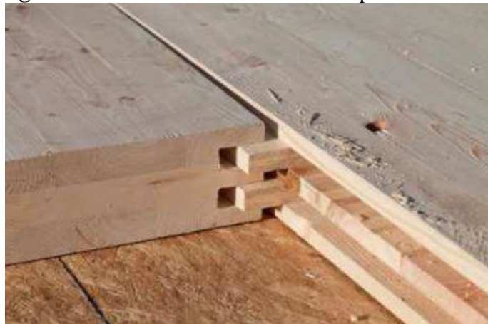
Figura 2.18 – Emendas dentadas entre painéis de CLT
