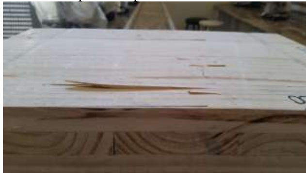
Figura 4.12 – Ruptura do painel P8 testado ao cisalhamento
