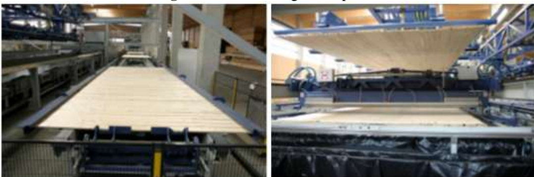
Figura 2.12 – Montagem do painel
