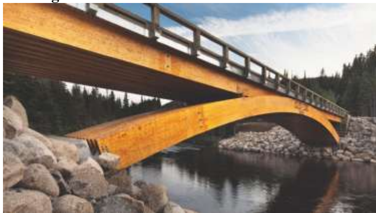
Figura 2.7 – Ponte em madeira laminada colada
