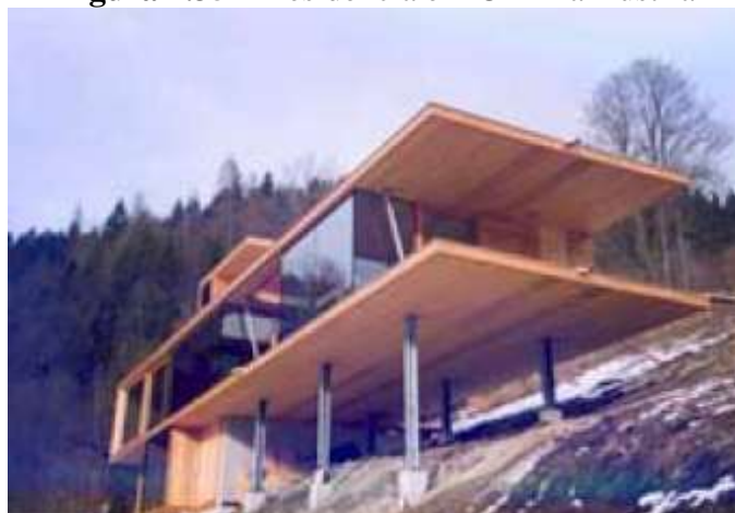
Figura 2.35 – Residência em CLT na Áustria
