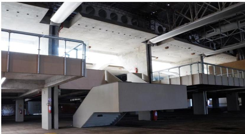
**Figura 73. Centro de Convenções de Pernambuco: vigas longitudinais de alma vazada em concreto, e vigas transversais metálicas.**
