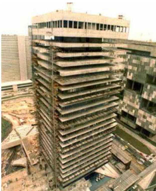
**Figura 42. BNDE-RJ: estrutura em concreto para o prédio.**
