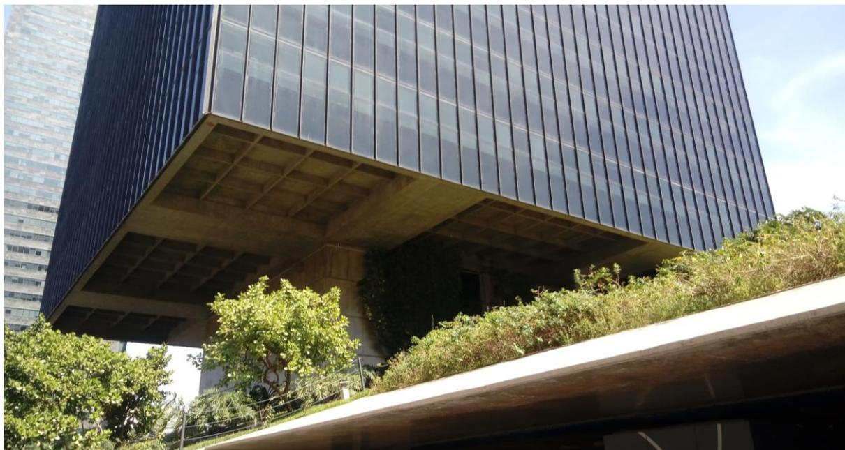
**Figura 43. BNDE-RJ: laje nervurada e viga caixão.**
