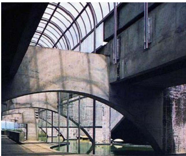
**Figura 75. Centro de convenções de Pernambuco: cobertura de vidro curvo e estrutura em alumínio.**
