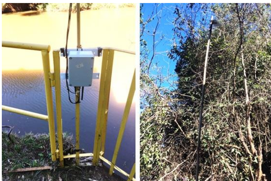
Figura 3-31 – Fixação do circuito e painel solar em P2
