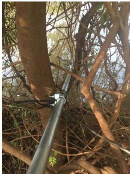
Figura 3-34 – Instalação dos sensores em P3
