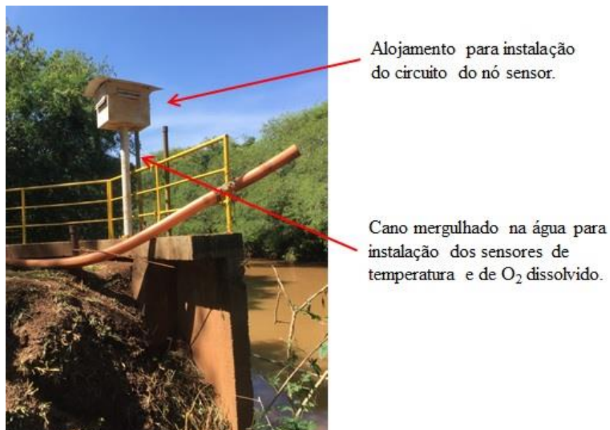
Figura 3-27 – Estrutura existente ns EEB-00
