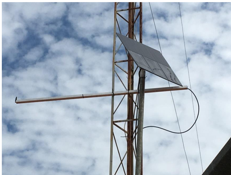
Figura 3-13 – Painéis solares para o nó central
