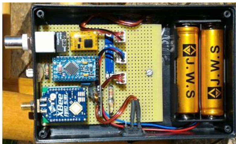
Figura 3-7 – Nó sensor montado em gabinete Patola
