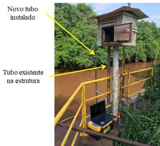
Figura 4-6 – Tubo novo instalado em P1
