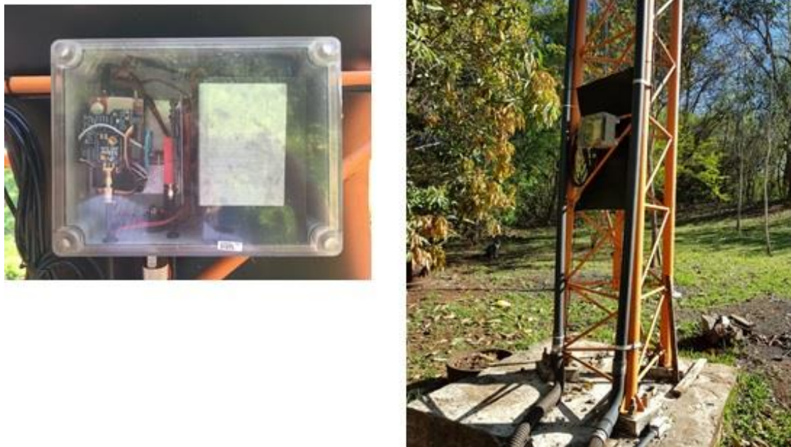
Figura 3-23 – Instalação do nó central
